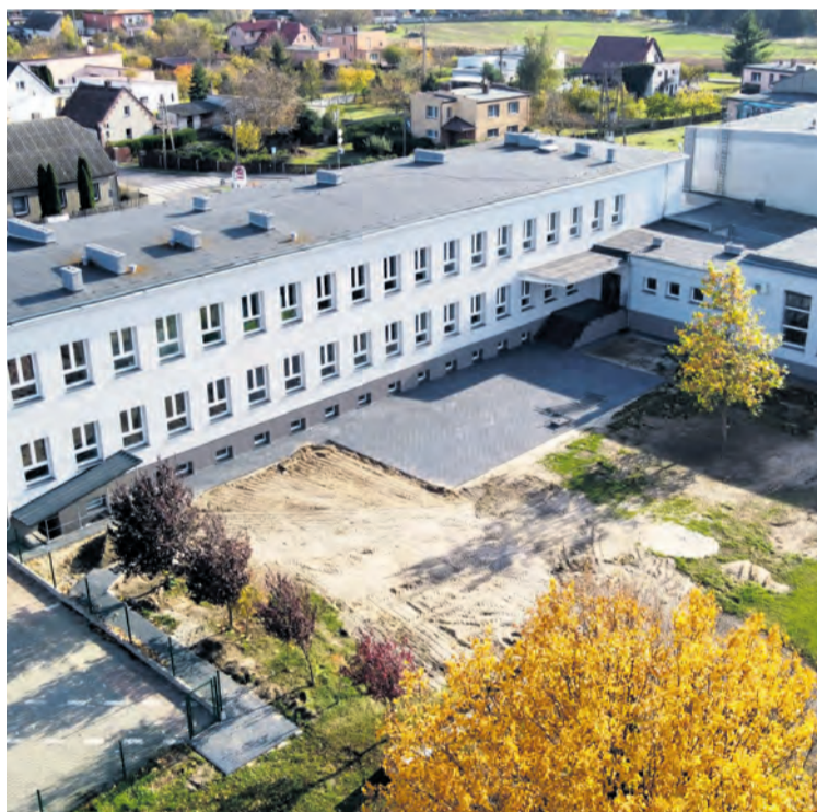
▲ Szkoła Podstawowa w Orzechowie zyskała m.in. nową elewację
