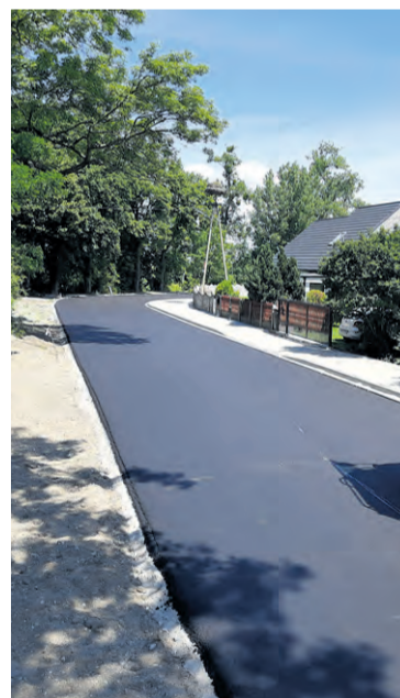
▲ Nowa droga w Biechówku
