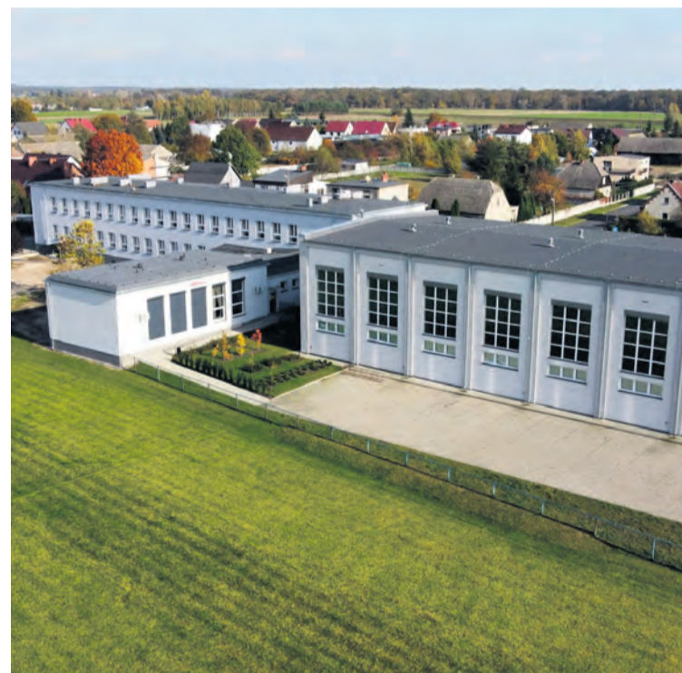
▲ Przeprowadzone prace przyniosą oszczędności, głównie na ogrzewaniu
