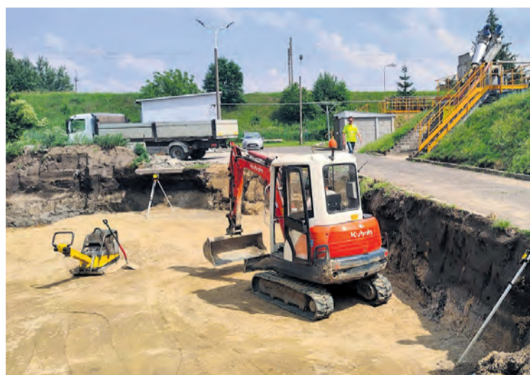
▲ Jednym z zadań jest budowa zbiornika retencyjno-uśredniającego
