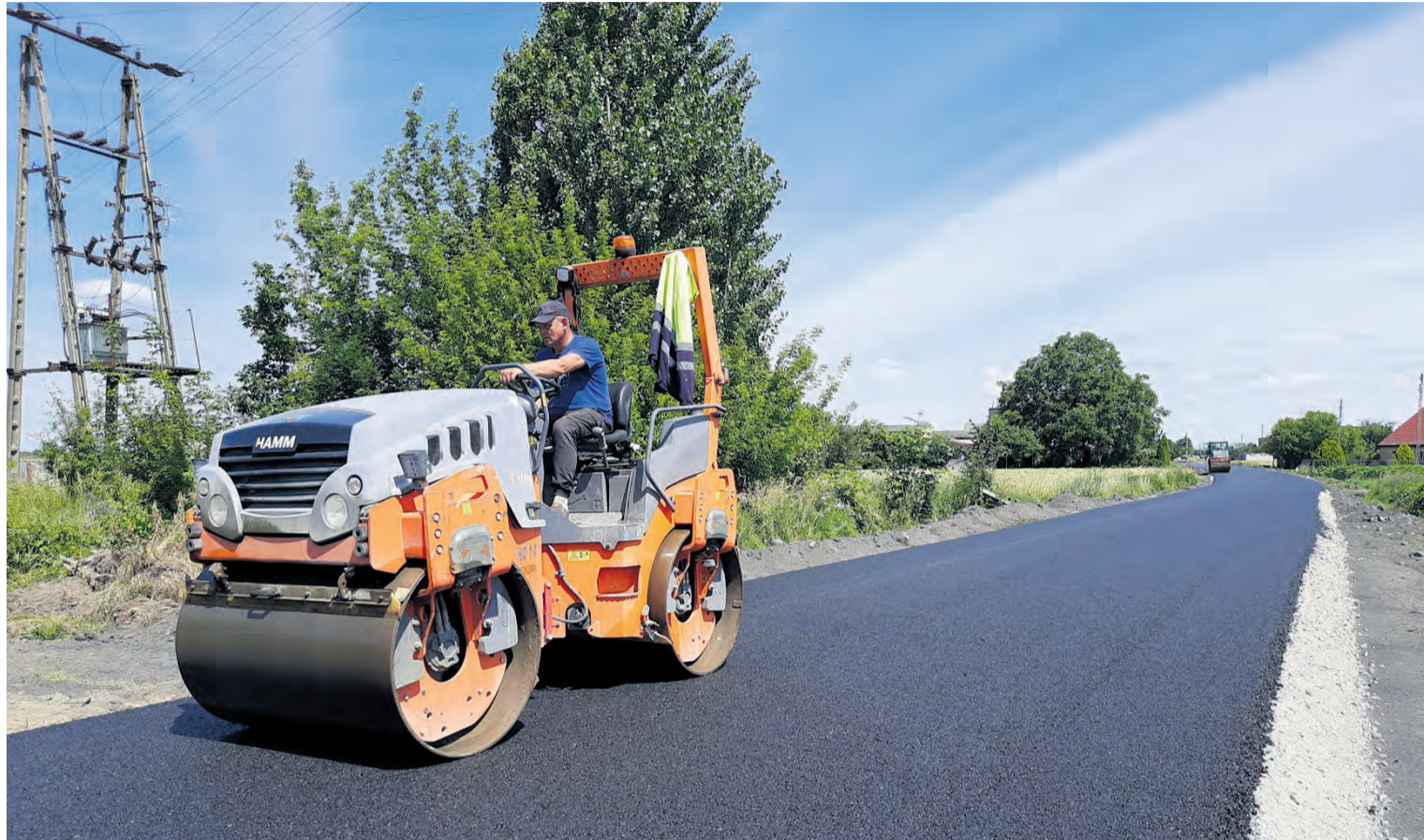
▲ Na drodze w Pałczynie w ubiegłym tygodniu pojawił się asfaltowy dywan. Roboty będą prowadzone jeszcze głównie na poboczach
